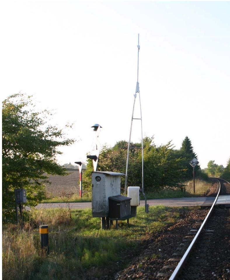
Foto 7 Overkørselsanlægget set fra øst - 2005
